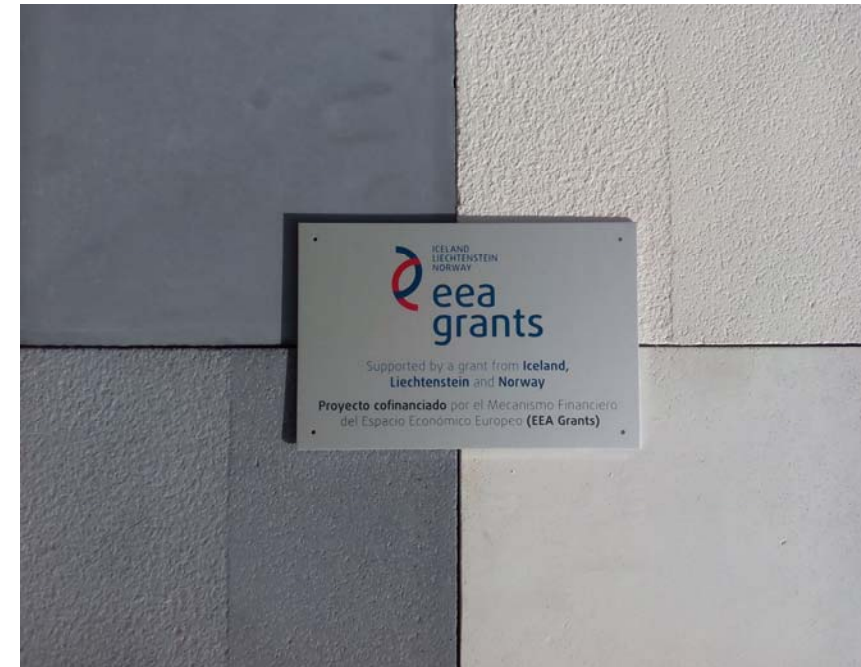
Paneles con el sistema ETIXc ; blanco y gris. Con y sin chorro de arena.
